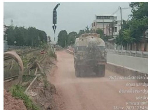
รูปที่ 2-34 ฉีดพรมน้ำบริเวณพื้นที่ก่อสร้าง
