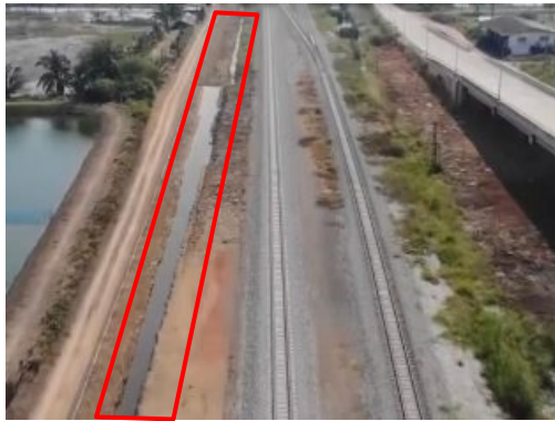
รูปที่ 2-32 ทางระบายน้ำชั่วคราว บริเวณพื้นที่ก่อสร้าง
