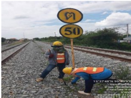
รูปที่ 2-36 ติดตั้งป้ายสัญญาณตามข้อบังคับและระเบียบการเดินรถ (ขตร.) ของการรถไฟแห่งประเทศไทย
