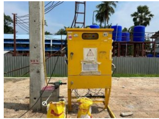
รูปที่ 2-18 ติดตั้งตู้ควบคุมไฟฟ้าในพื้นที่ก่อสร้าง พร้อมการตรวจเช็คอุปกรณ์ไฟฟ้าที่ใช้ในการทำงาน
