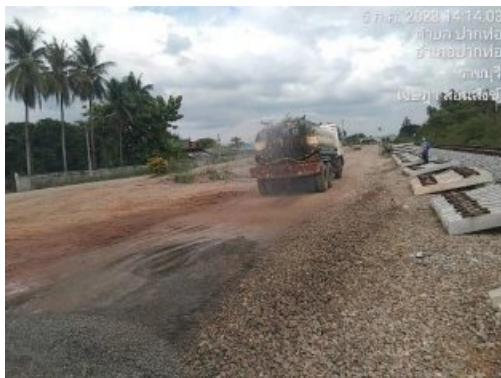
รูปที่ 2-34 ฉีดพรมน้ำบริเวณพื้นที่ก่อสร้าง
