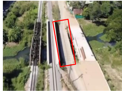
รูปที่ 2-33 สะพานเหล็กชั่วคราว สำหรับขนส่งวัสดุ
