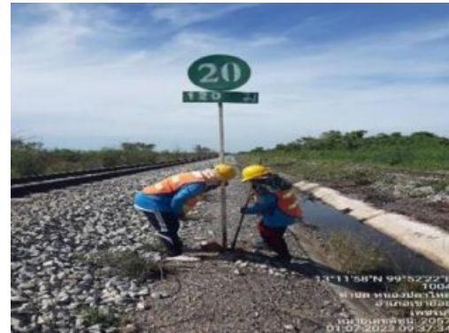
รูปที่ 2-36 ติดตั้งป้ายสัญญาณตามข้อบังคับและระเบียบการเดินรถ (ขตร.) ของการรถไฟแห่งประเทศไทย
