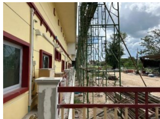
รูปที่ 2-29 การติดตั้งบันได นั่งร้านและราวกันตก
