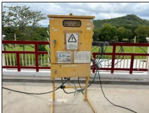
รูปที่ 2-18 ติดตั้งตู้ควบคุมไฟฟ้าในพื้นที่ก่อสร้าง พร้อมการตรวจเช็คอุปกรณ์ไฟฟ้าที่ใช้ในการทำงาน
