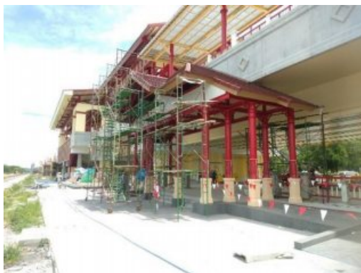
รูปที่ 2-29 การติดตั้งบันได นั่งร้านและราวกันตก
